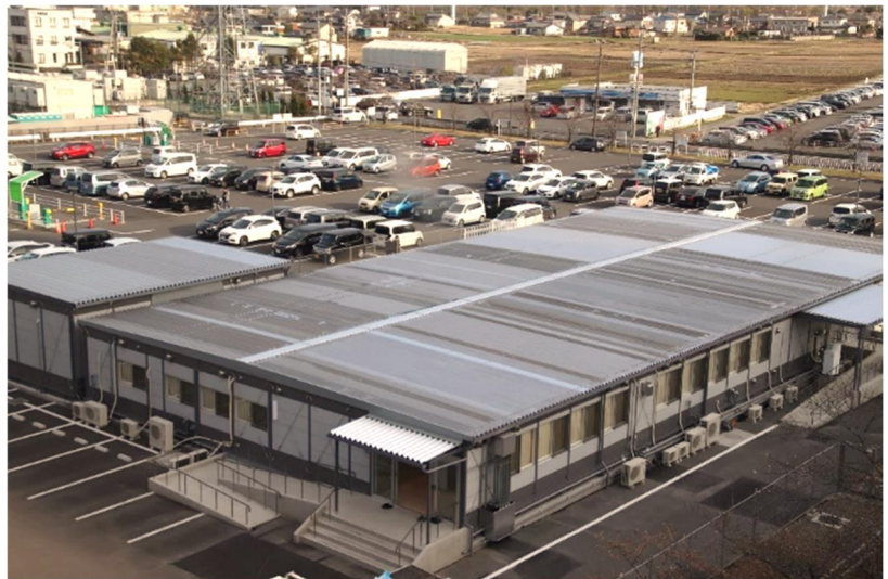
完成したプレハブ病棟内部（写真上）、病棟全景（写真下）
